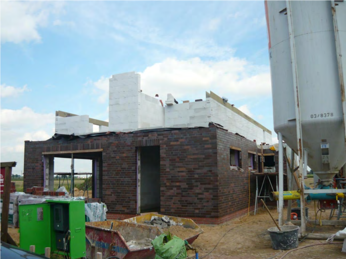
Erstellung des Mauerwerkes des Obergeschosses
