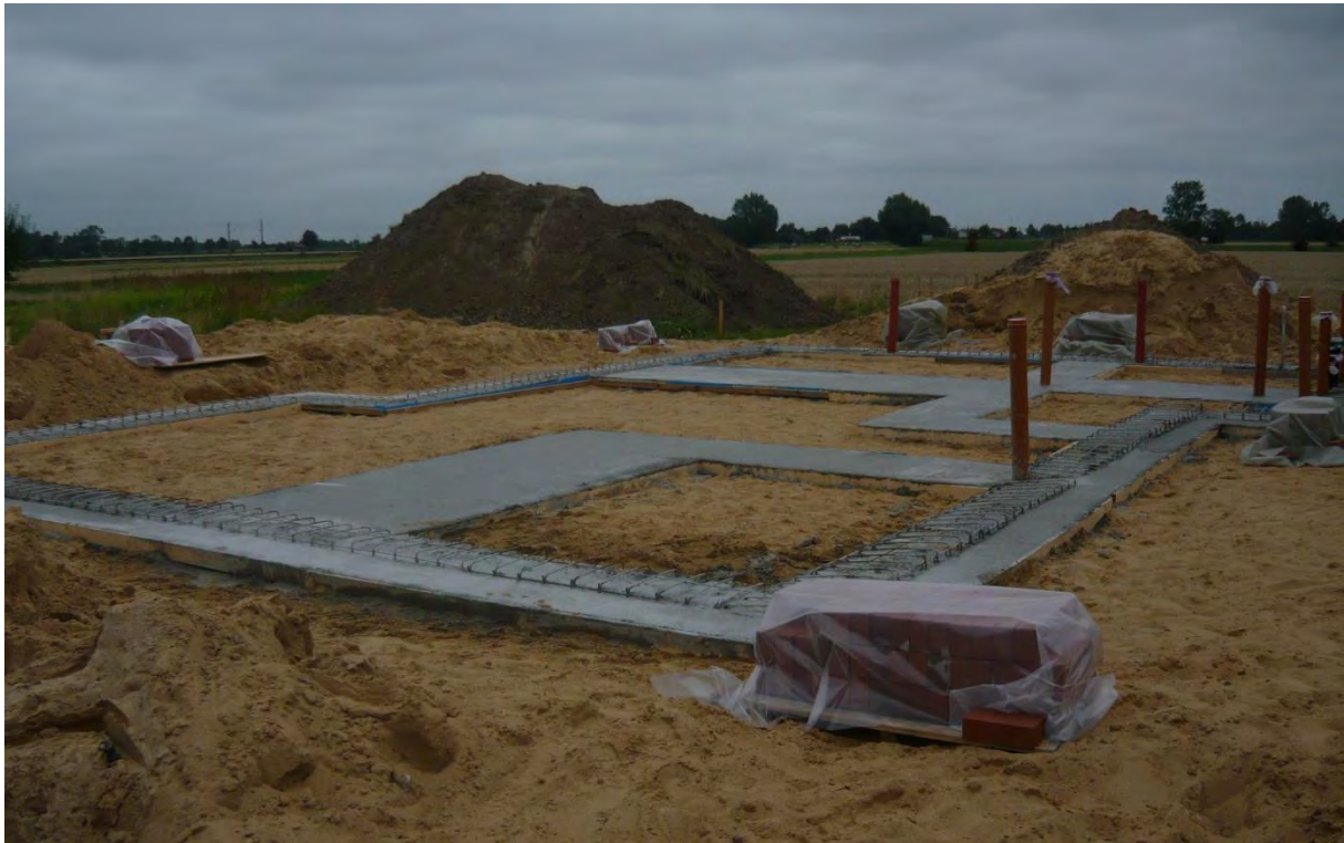
Streifenfundamente nach Fertigstellung
