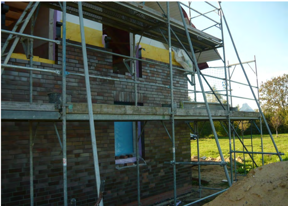
Erstellung Verblendmauerwerk
