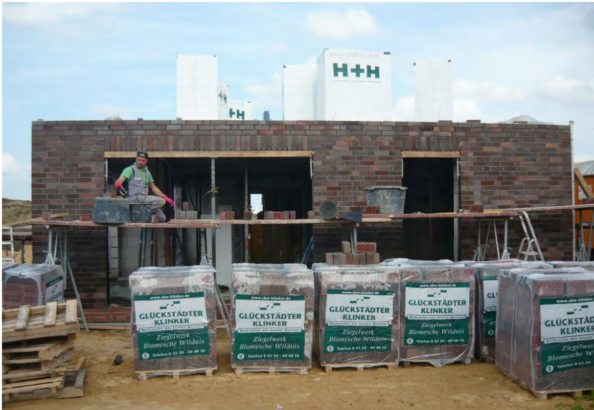
Erstellung des Verblendmauerwerkes
