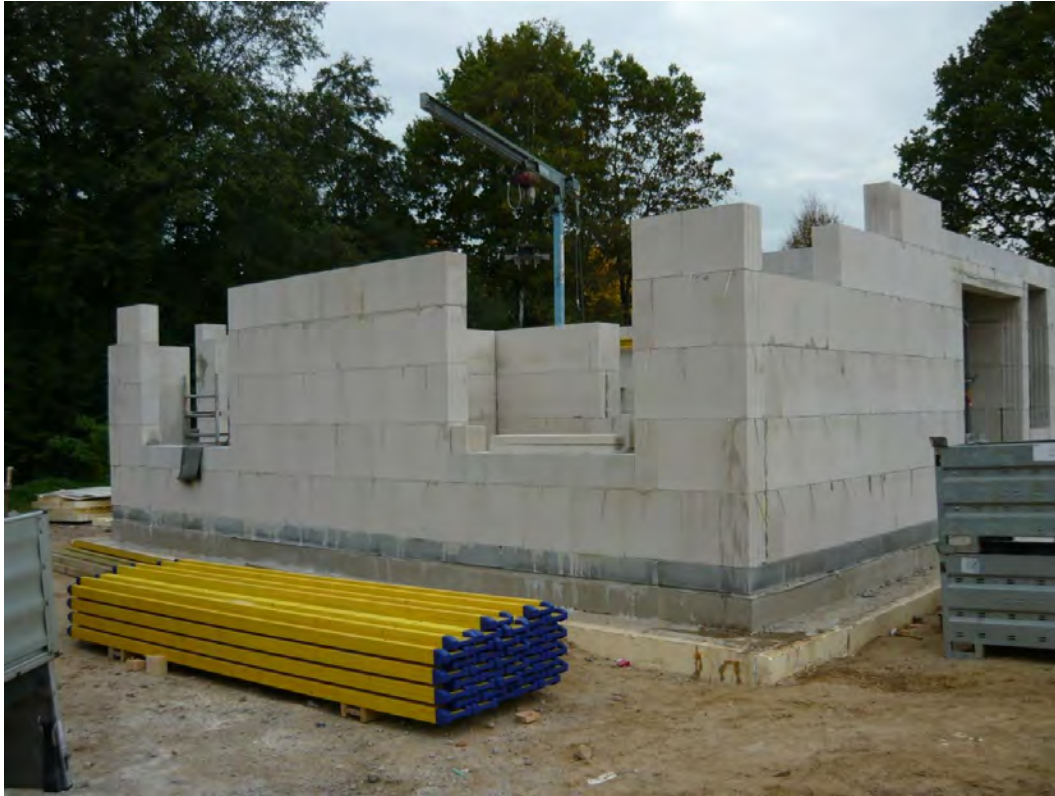
EG-Hintermauerwerk während der Rohbauarbeiten
