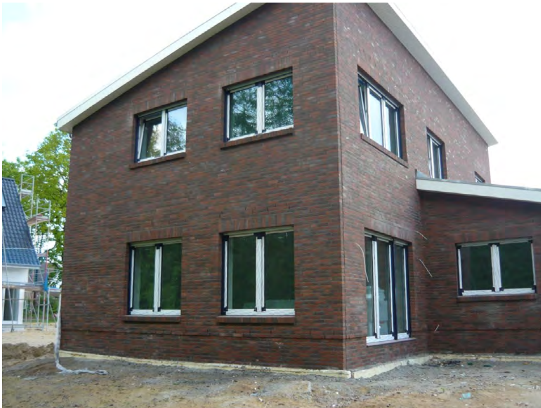
Einfamilienhaus nach Fertigstellung der Rohbauarbeiten
