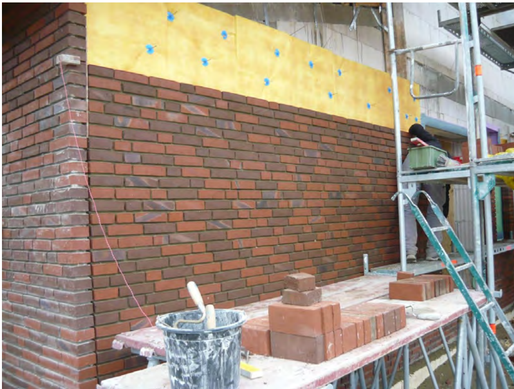
Verblendmauerwerk während der Rohbauarbeiten
