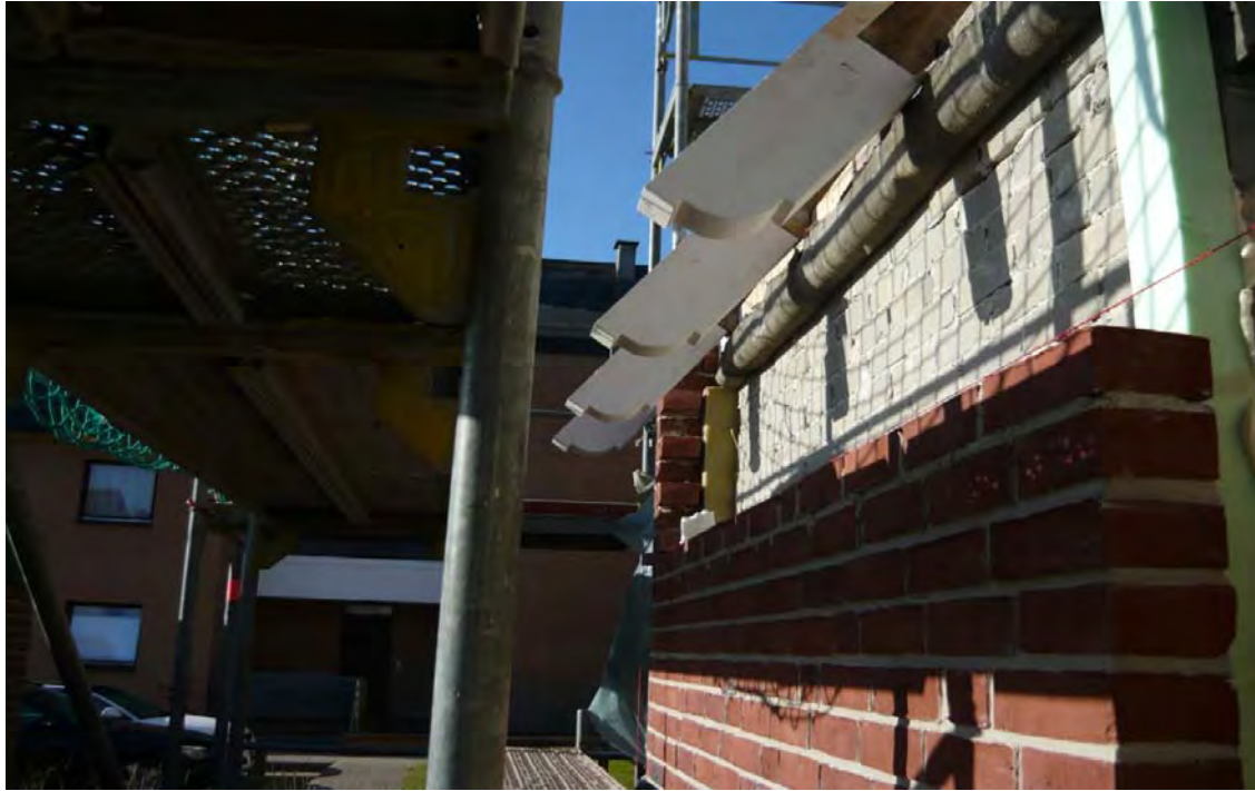
Neu hergestellte sichtbare Sparrenköpfe
