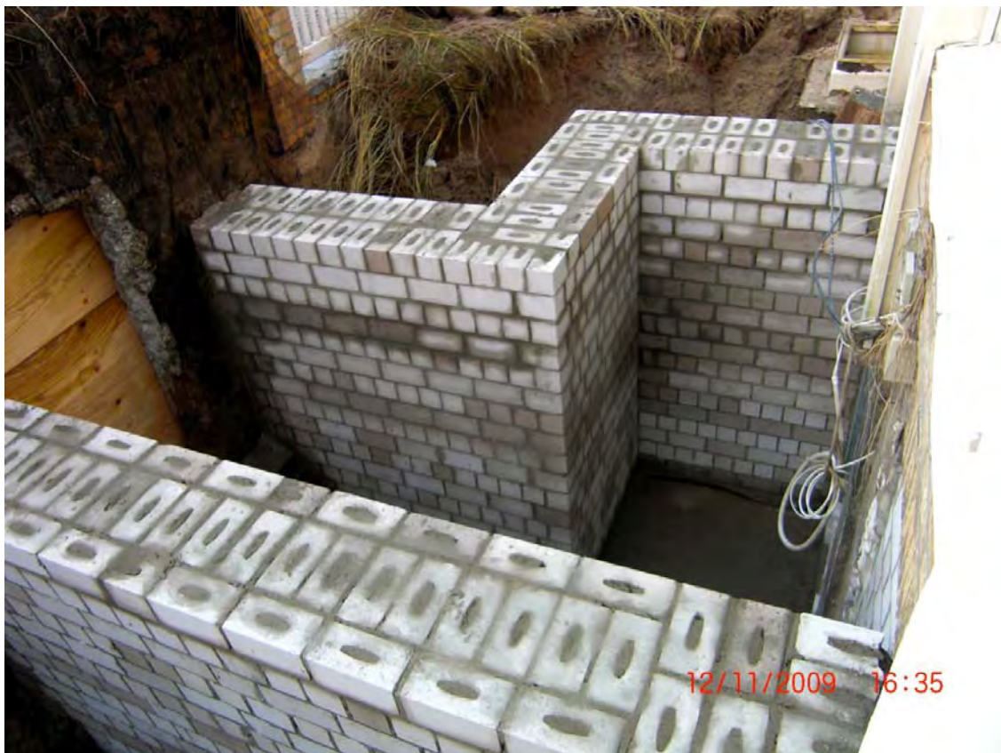
Außenwände des Verbindungstunnel zwischen Kellergeschoss und der Tiefgarage
