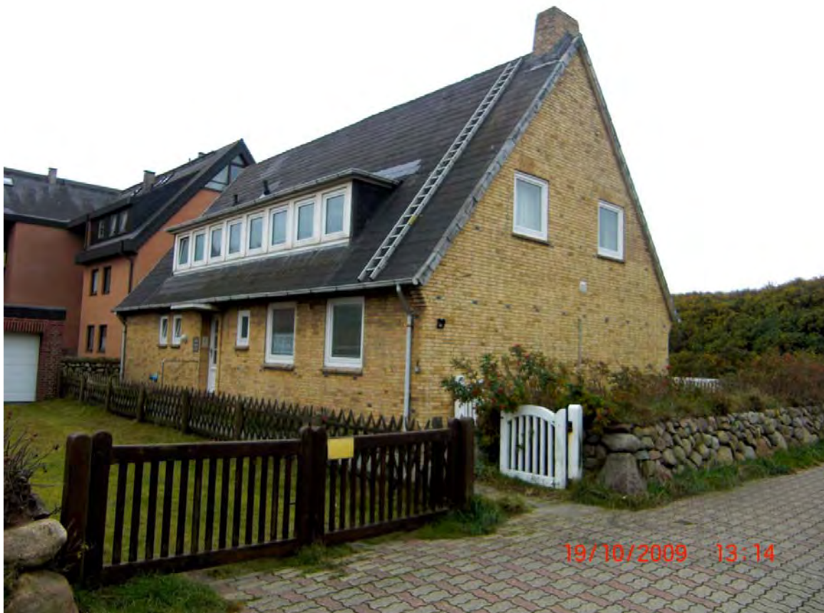
Ansicht bei Beginn der Baumaßnahme
