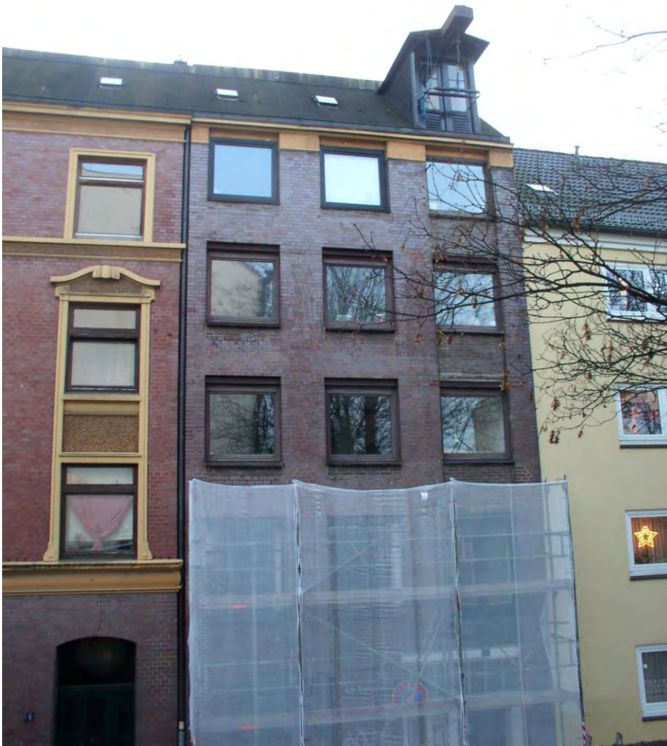
Fassade vor Beginn der Arbeiten
