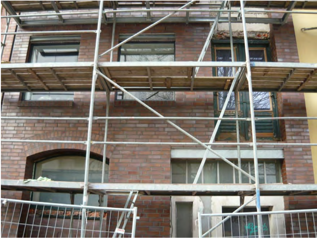
Fassade nach Abschluss der Maurerarbeiten
