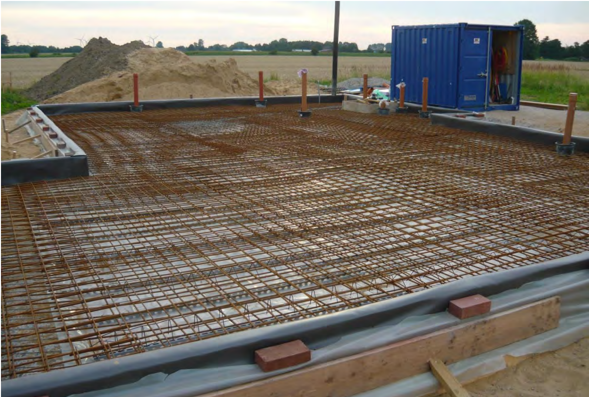
Verlegte Bewehrung der Bodenplatte
