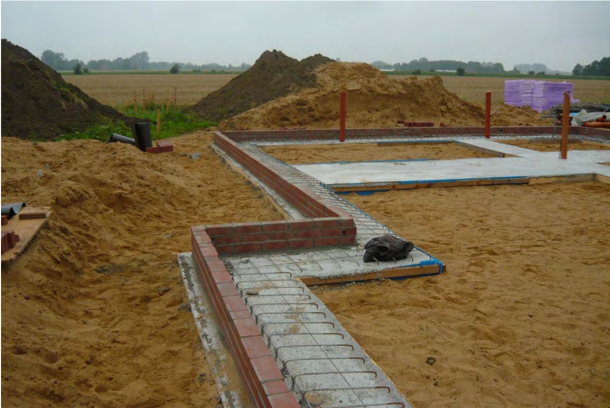
Sockelmauerwerk
