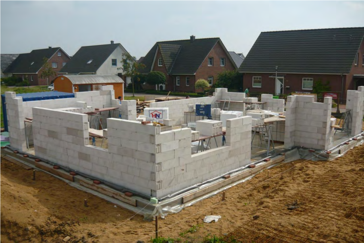
Hintermauerwerk des Erdgeschosses
