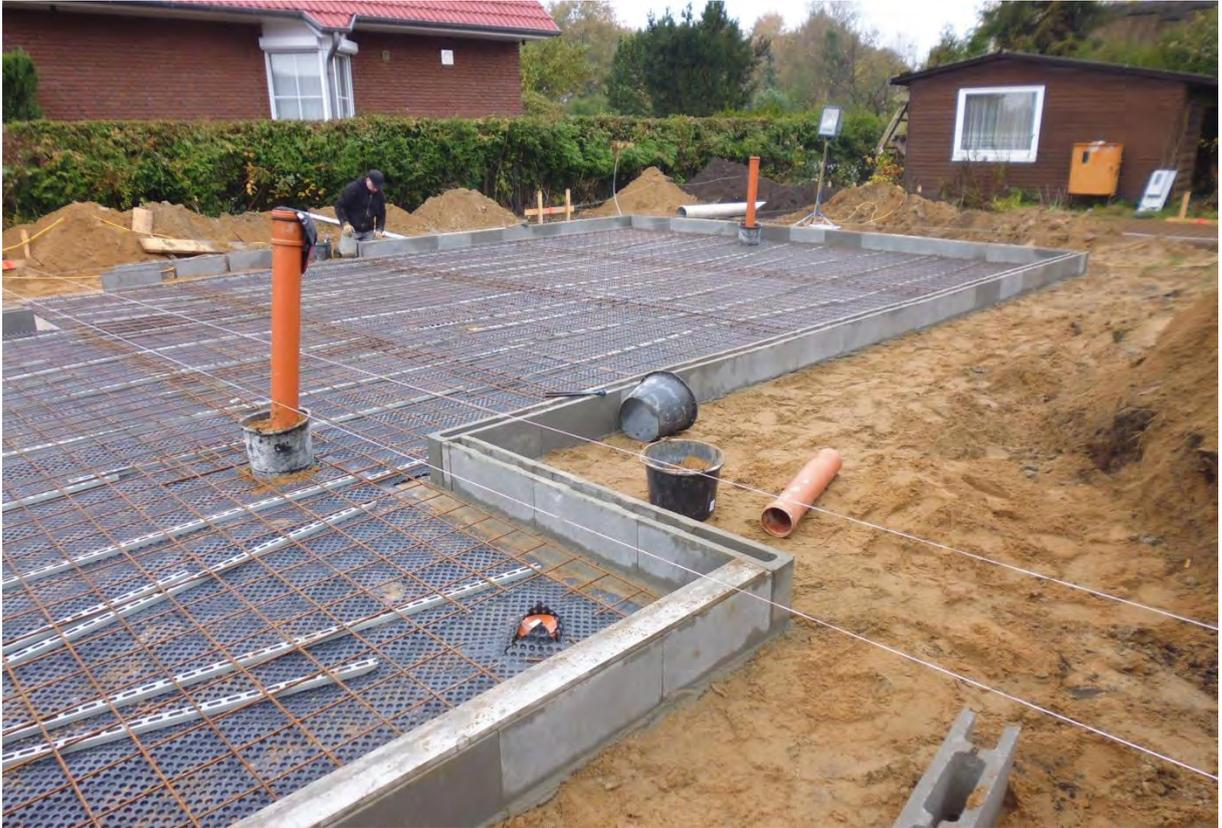
Herstellung des Sockelmauerwerkes aus Betonschalungssteinen
