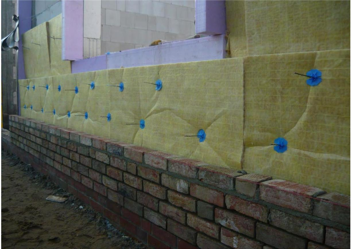
Kerndämmung der 2-schaligen Verblendfassade
