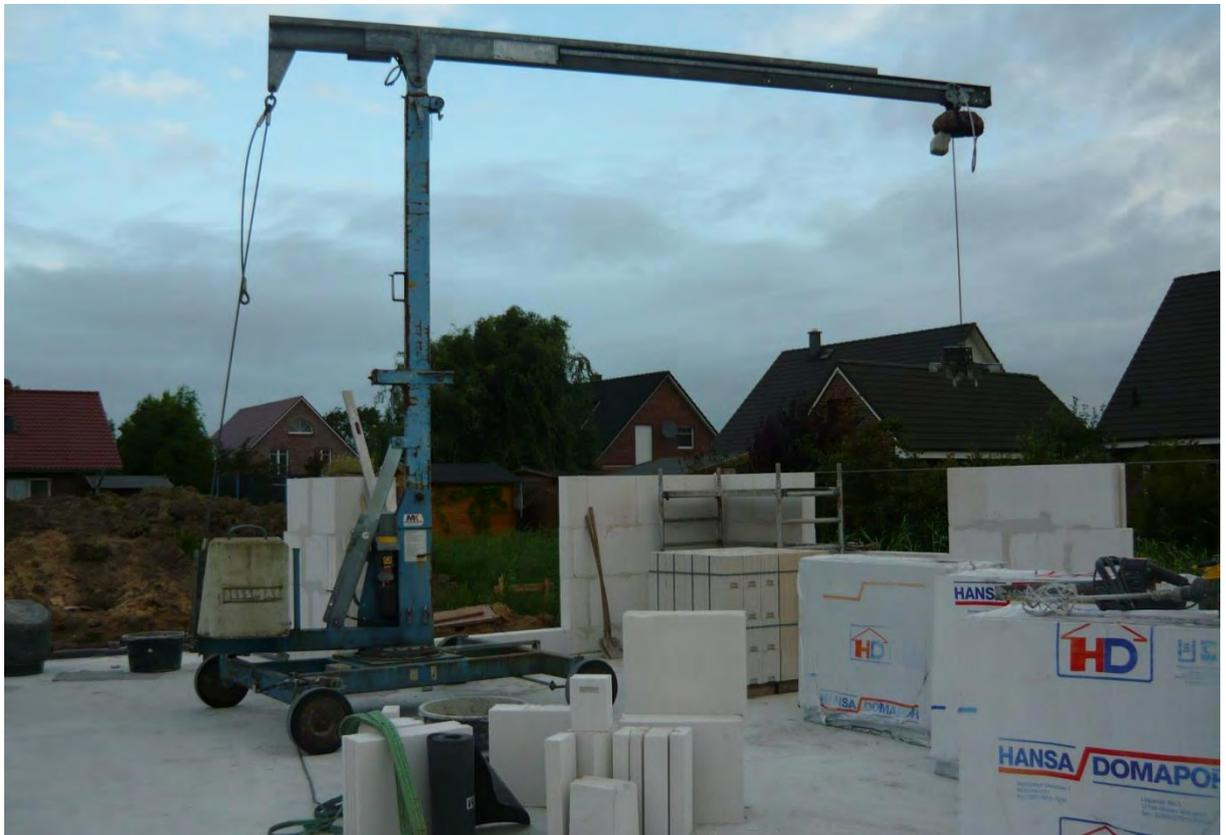
Herstellung der Erdgeschoss-Außenwände aus Porenbeton-Planelementen mit Minikran
