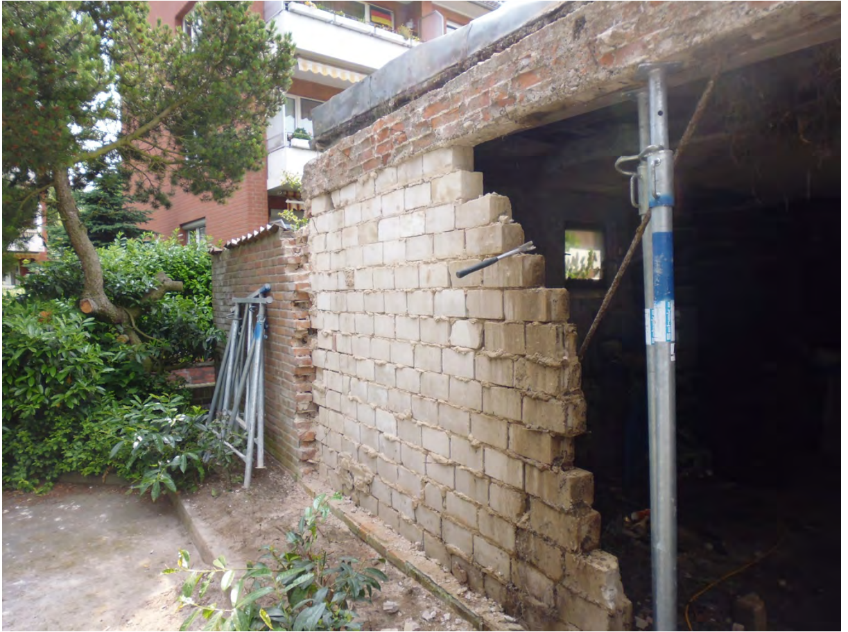
Abbruch der durch Feuchtigkeit geschädigten Garagenrückwand
