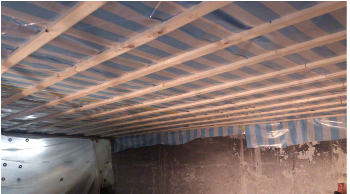
Neue Dachkonstruktion einschließlich Dämmung und Dampfsperrfolie im Zuge der Trockenbauarbeiten
