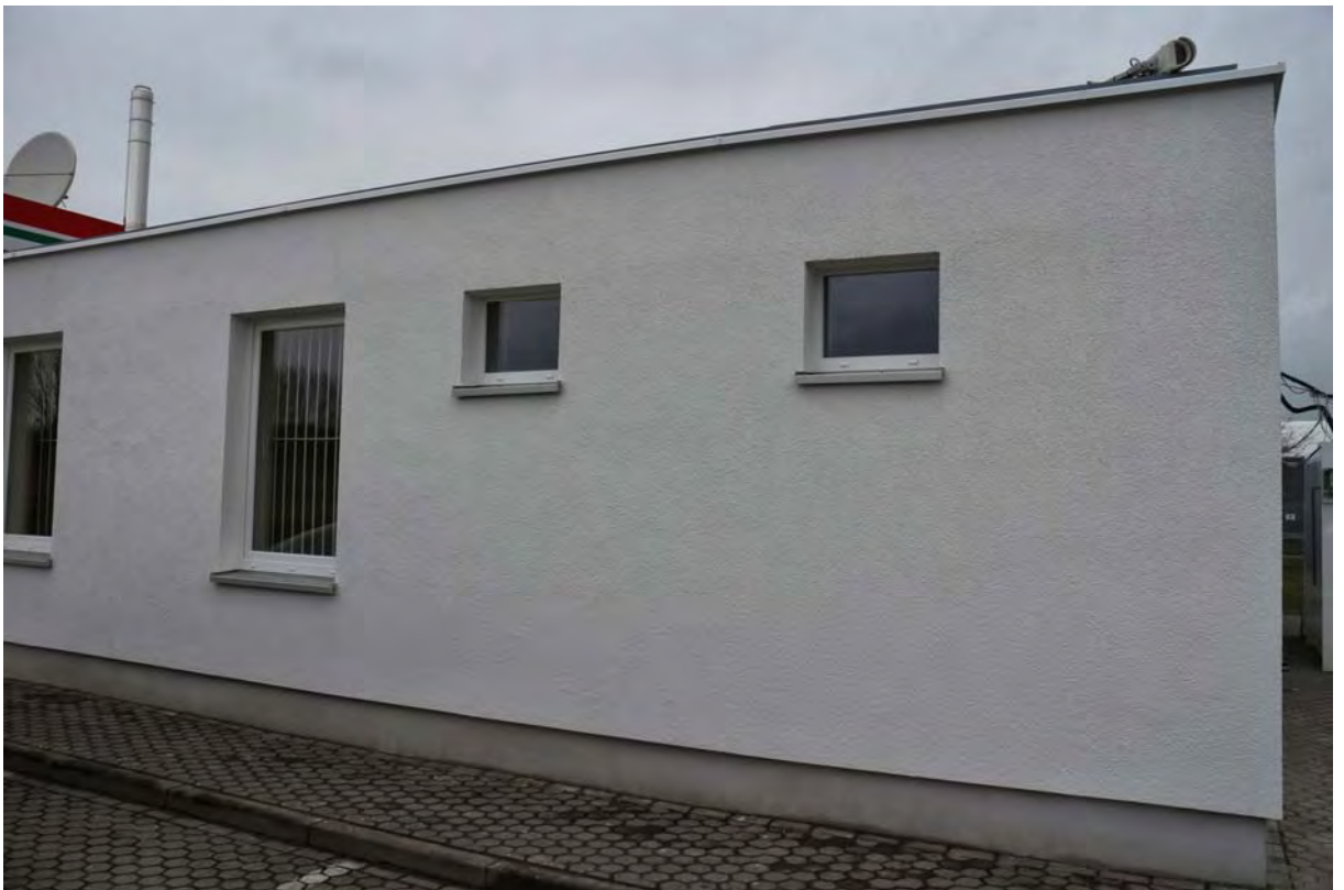
WDVS-Fassade nach Fertigstellung
