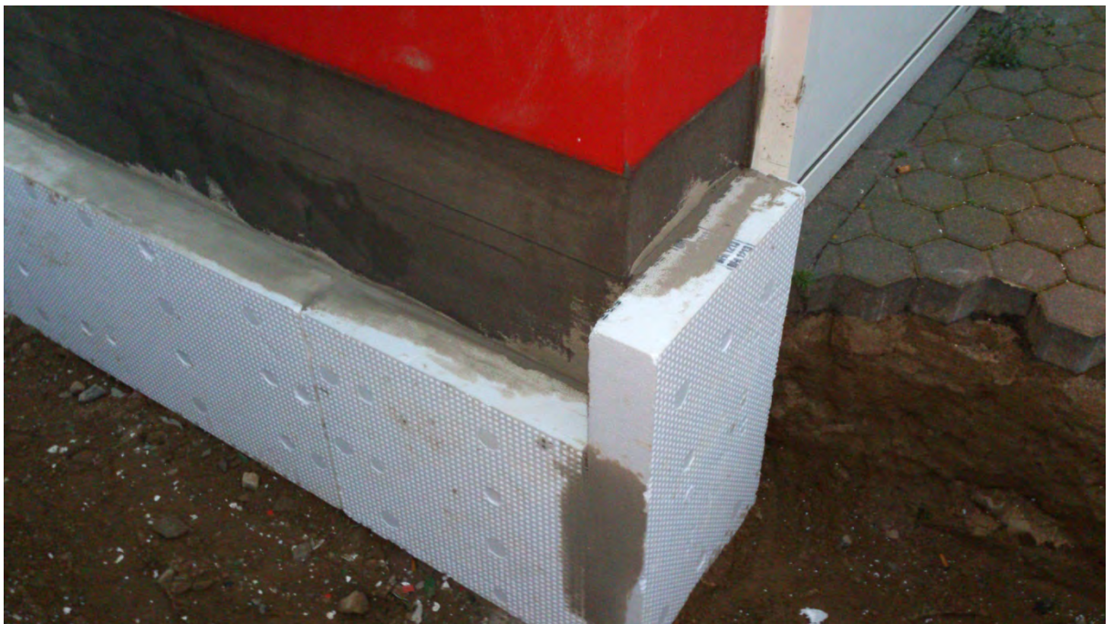
Sockeldämmung und Abdichtung der Fassade
