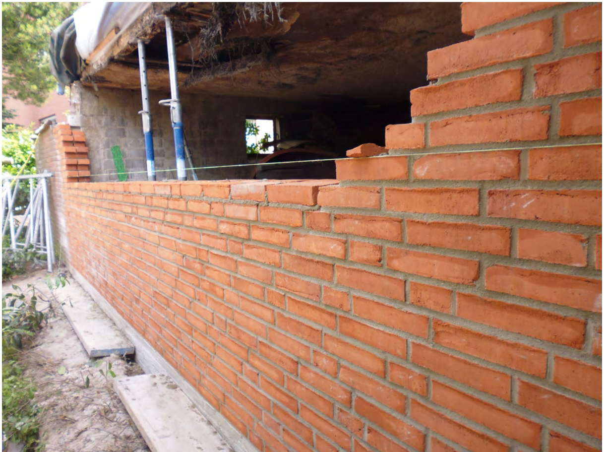
Herstellen der neuen Rückwand als Sichtmauerwerk
