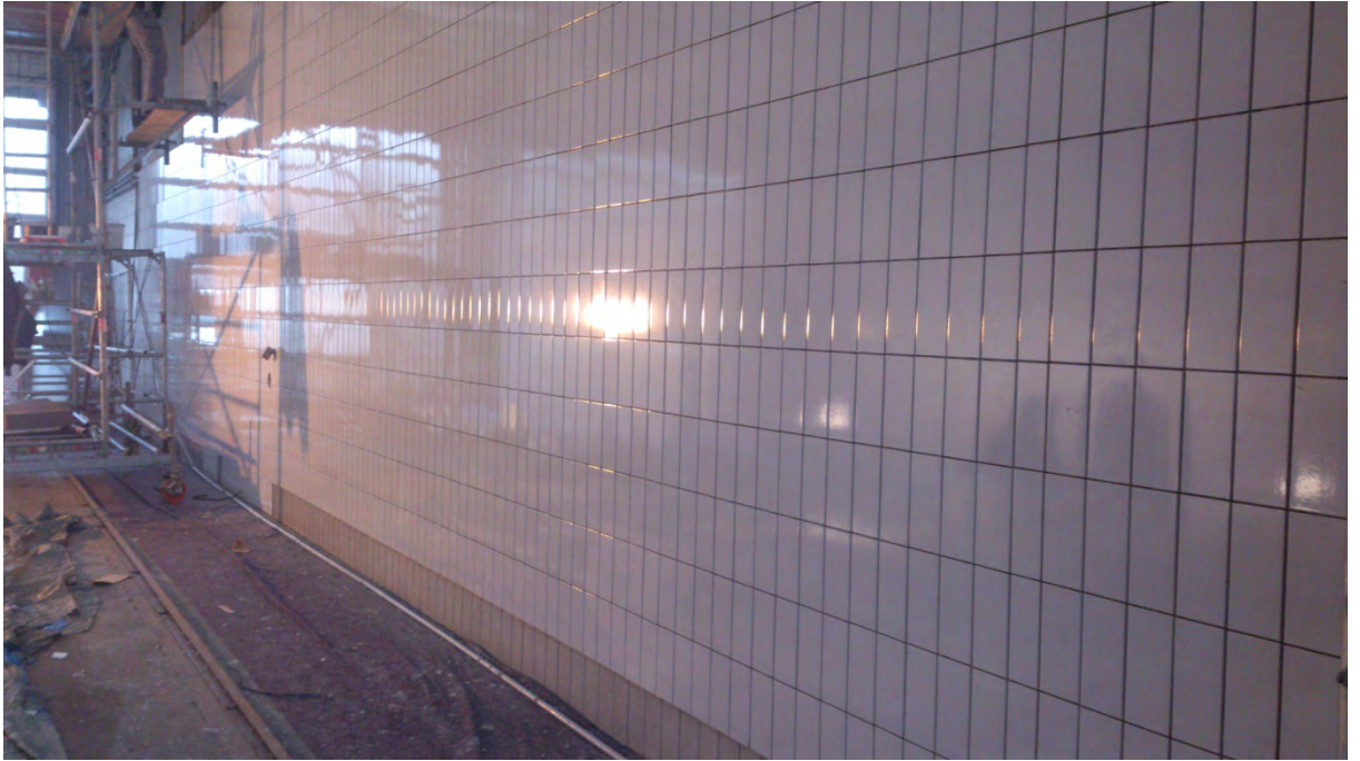
Neuer Wandfliesenbelag in der LKW-Waschhalle
