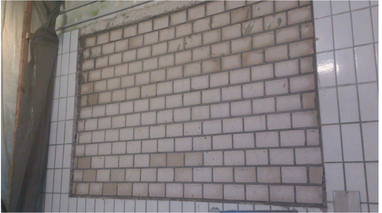
Ausmauern von Öffnungen
