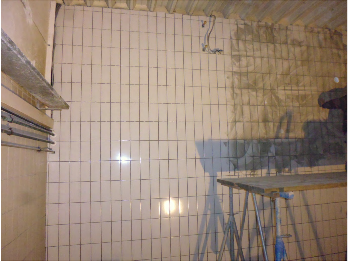
Neu erstellter Wandfliesenbelag während des Verfugens
