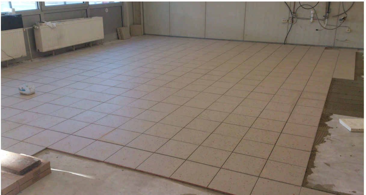
Neu verlegte Bodenfliesen im Tankstellenshopbereich
