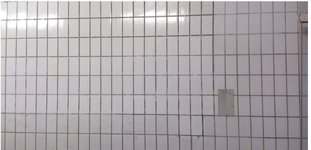
Neu verlegte Wandfliesen im Bereich der ausgemauerten Öffnungen
