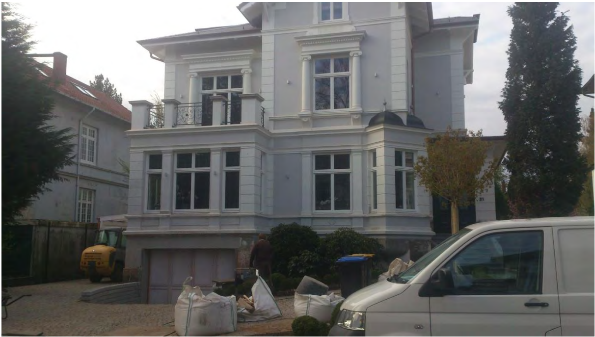
Straßenansicht kurz vor Fertigstellung der Arbeiten
