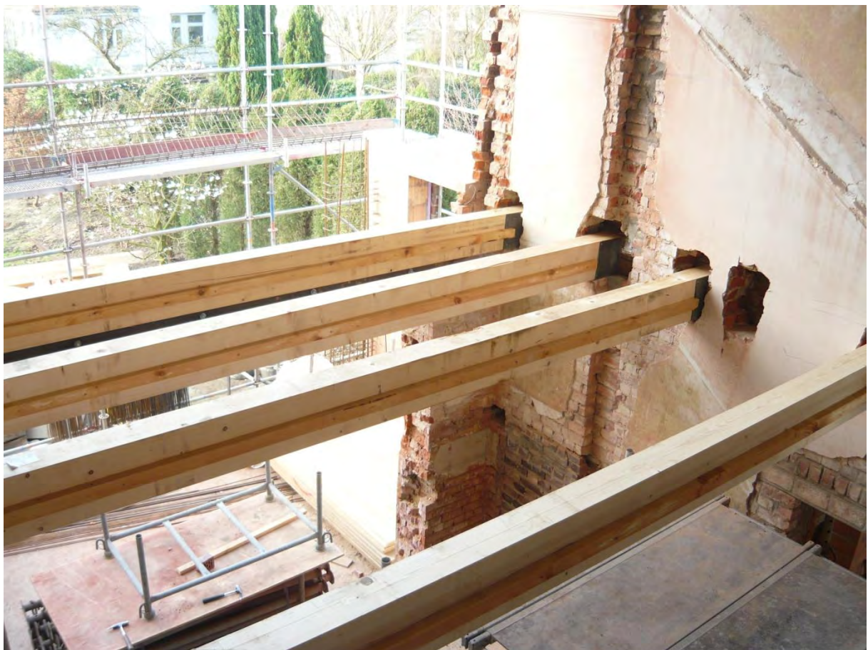
Einabu von neuen Deckenbalken in den Geschossen
