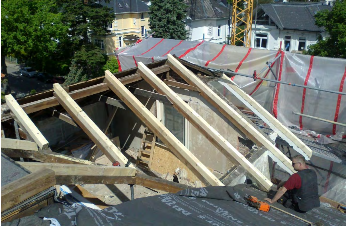
Dachstuhl des Altbaus während der Sanierung
