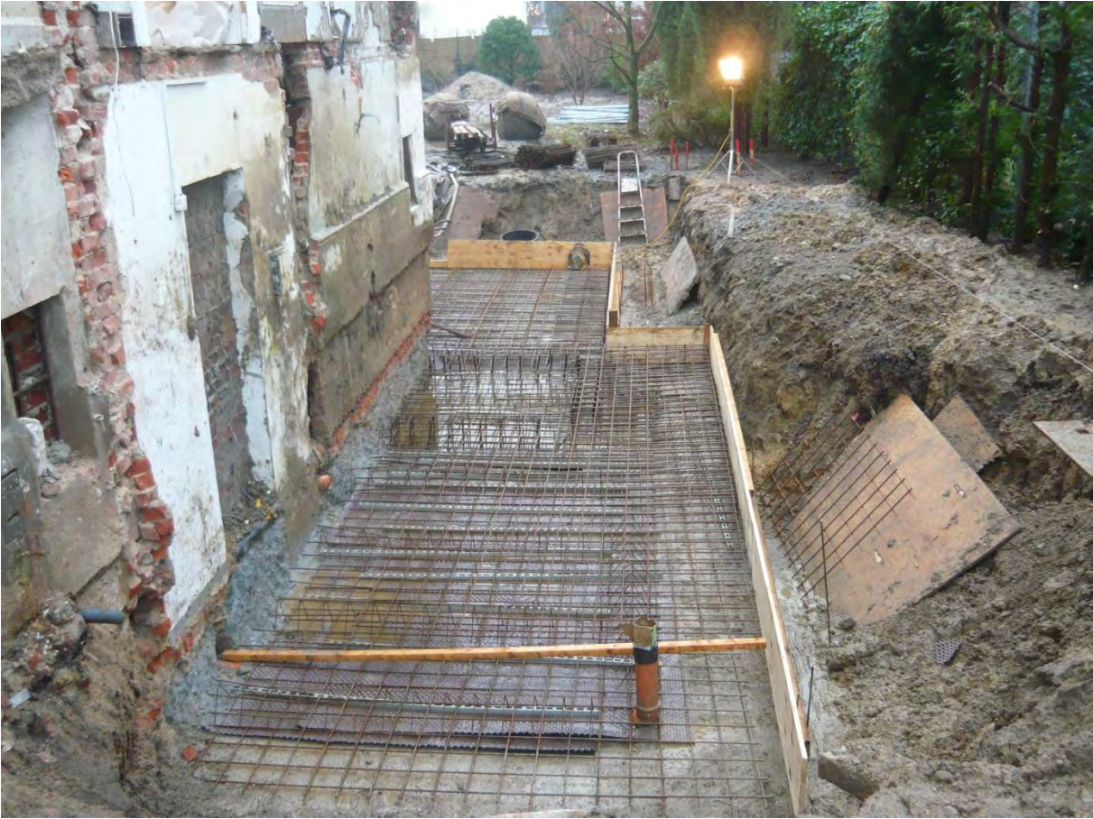
Bewehrung der Gründungssohle des seitlichen Anbaus
