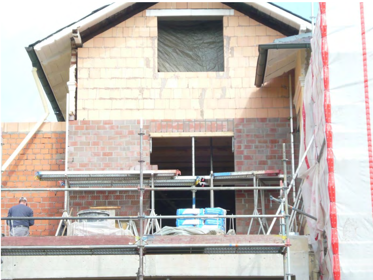
Neu erstelltes Giebelmauerwerk
