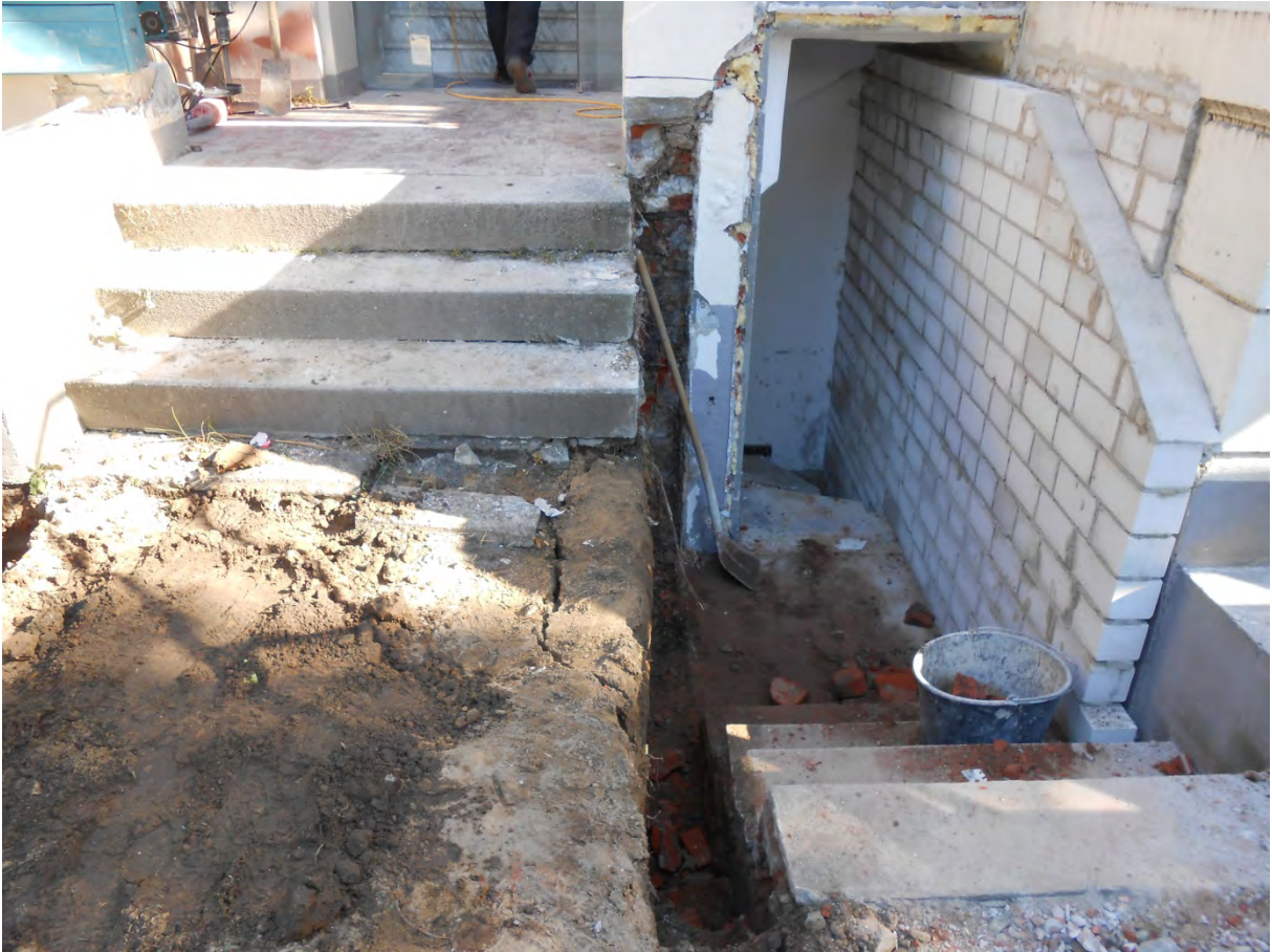
Vorhandenes Eingangspodest bei Beginn der Abbrucharbeiten
