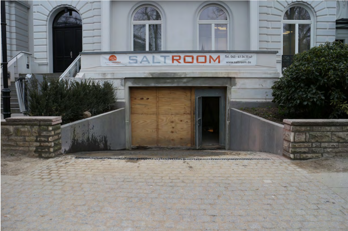
Zufahrt und Fassadenöffnung zur Tiefgarage
