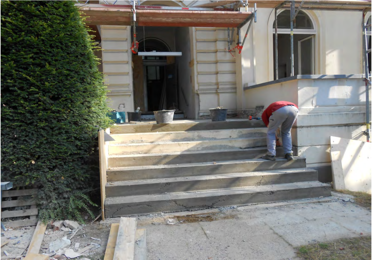
Neue Treppenanlage nach Fertigstellung der Betonarbeiten
