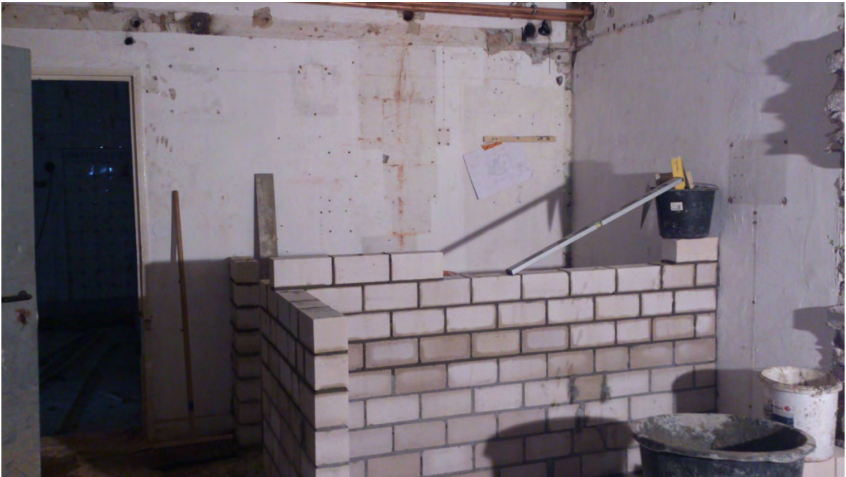
Mauerwerk der neuen Innenwände im Kellergeschoss
