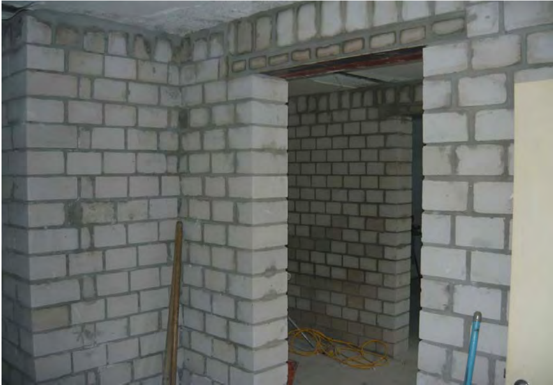
Aufmauern von neuen Innenwänden im EG
