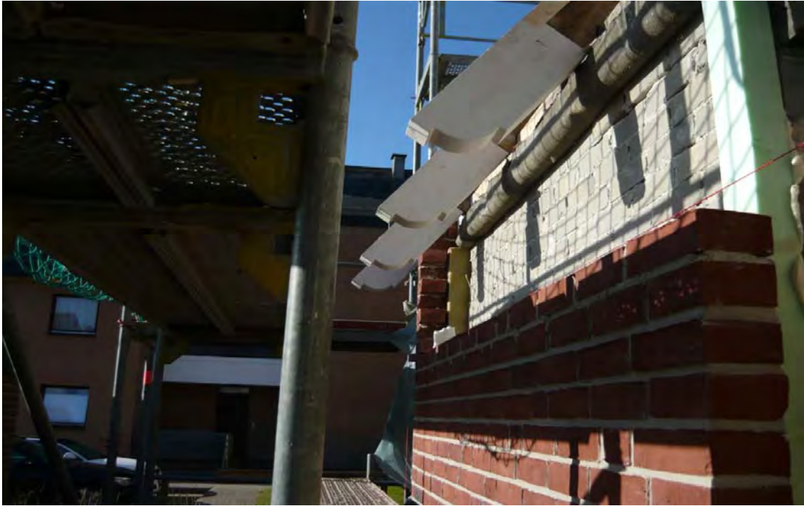
Neu hergestellte sichtbare Sparrenköpfe
