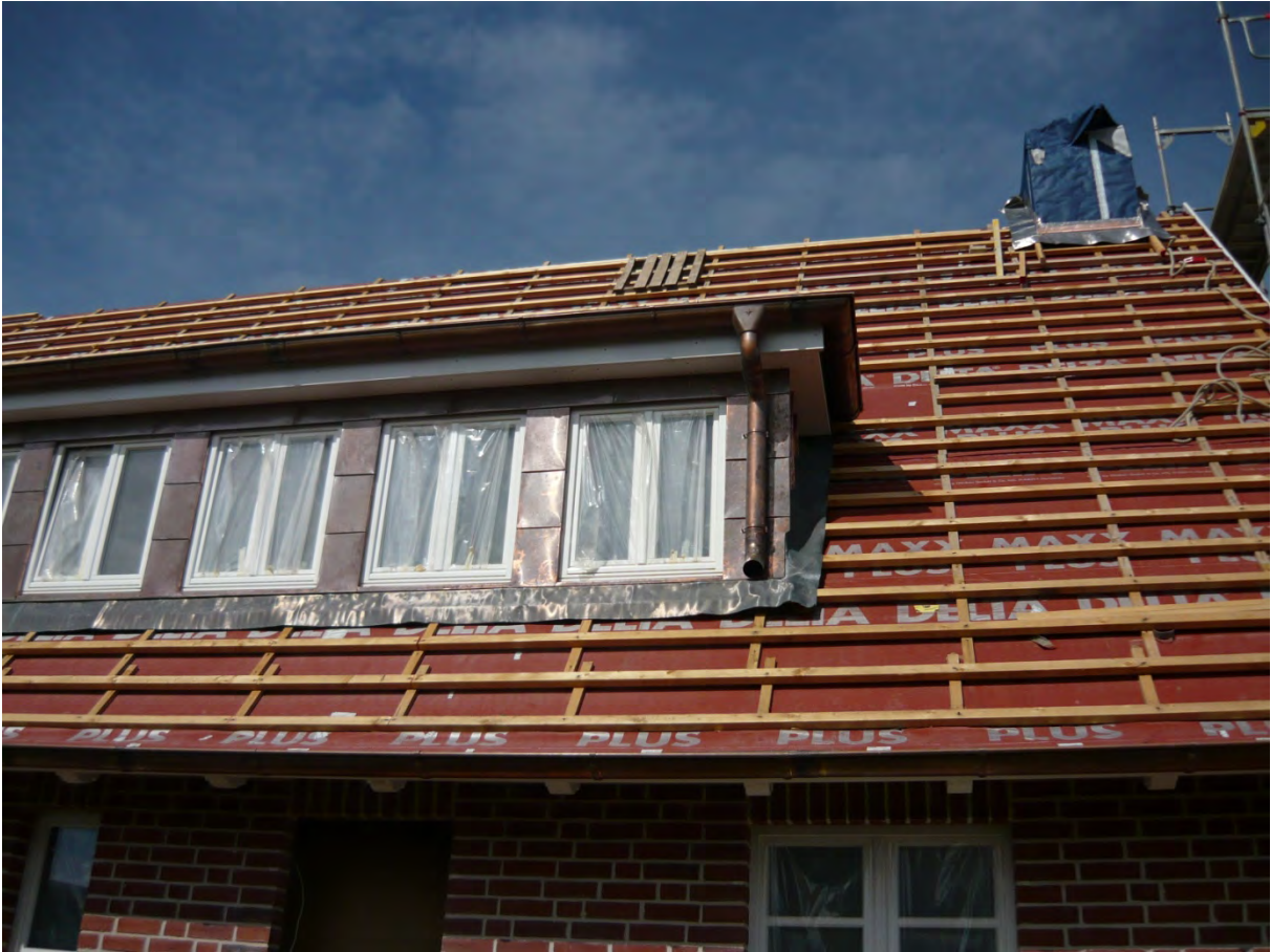
Zur Dacheindeckung vorbereitete Dachfläche
