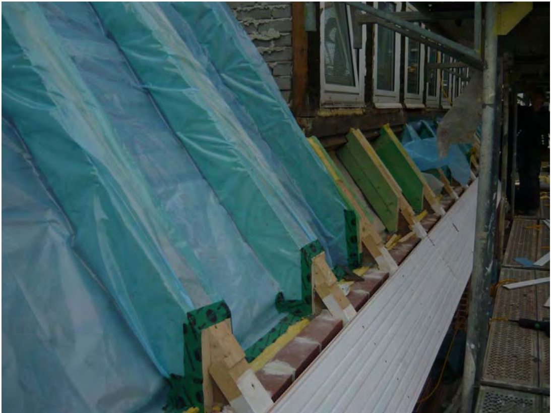
Dachsanierung während der Zimmererarbeiten
