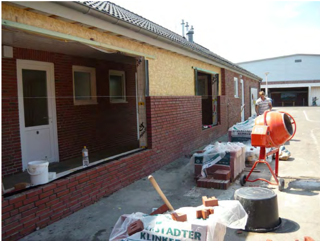
Verbindungsgang während der Rohbauarbeiten
