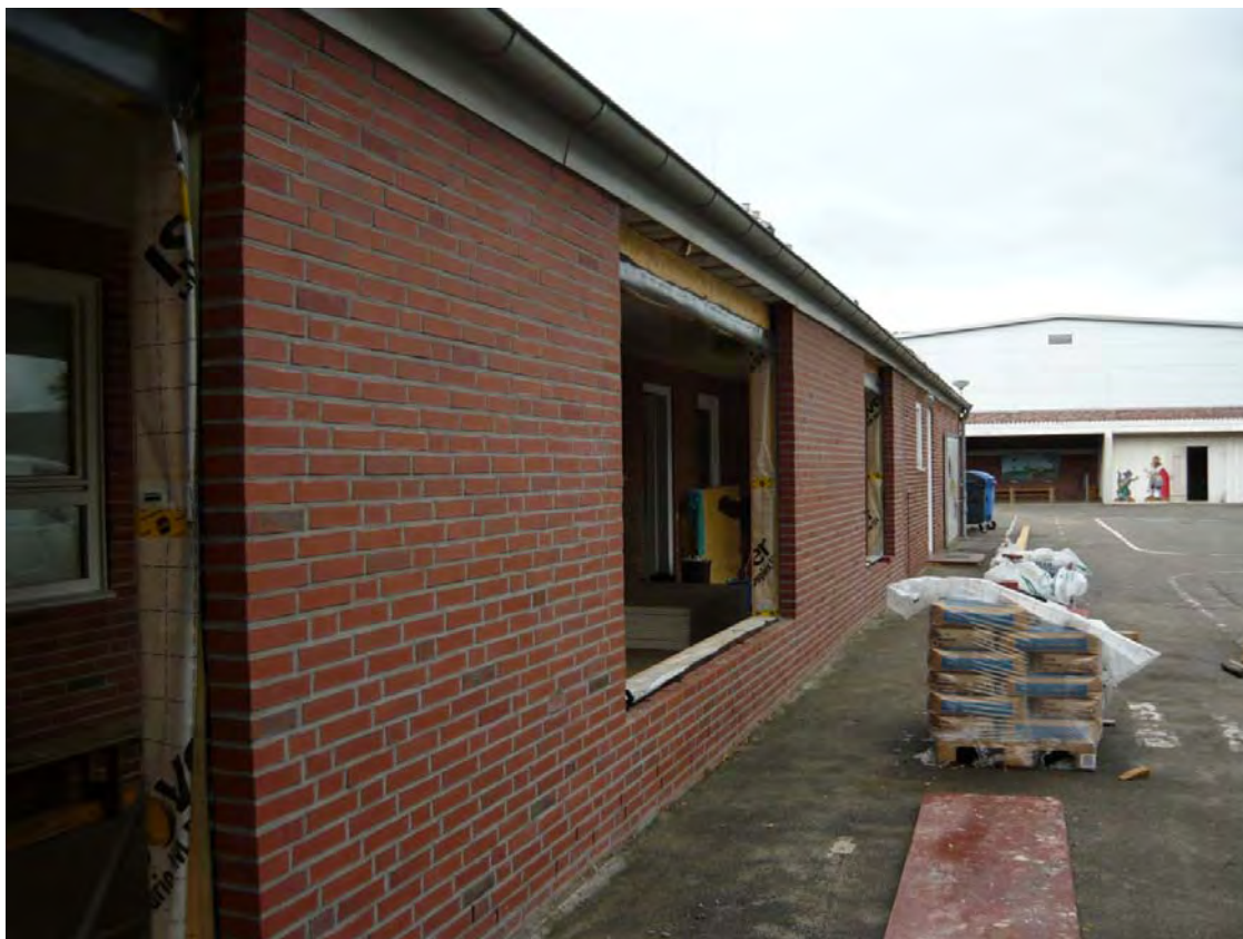
Verbindungsgang nach Fertigstellung
