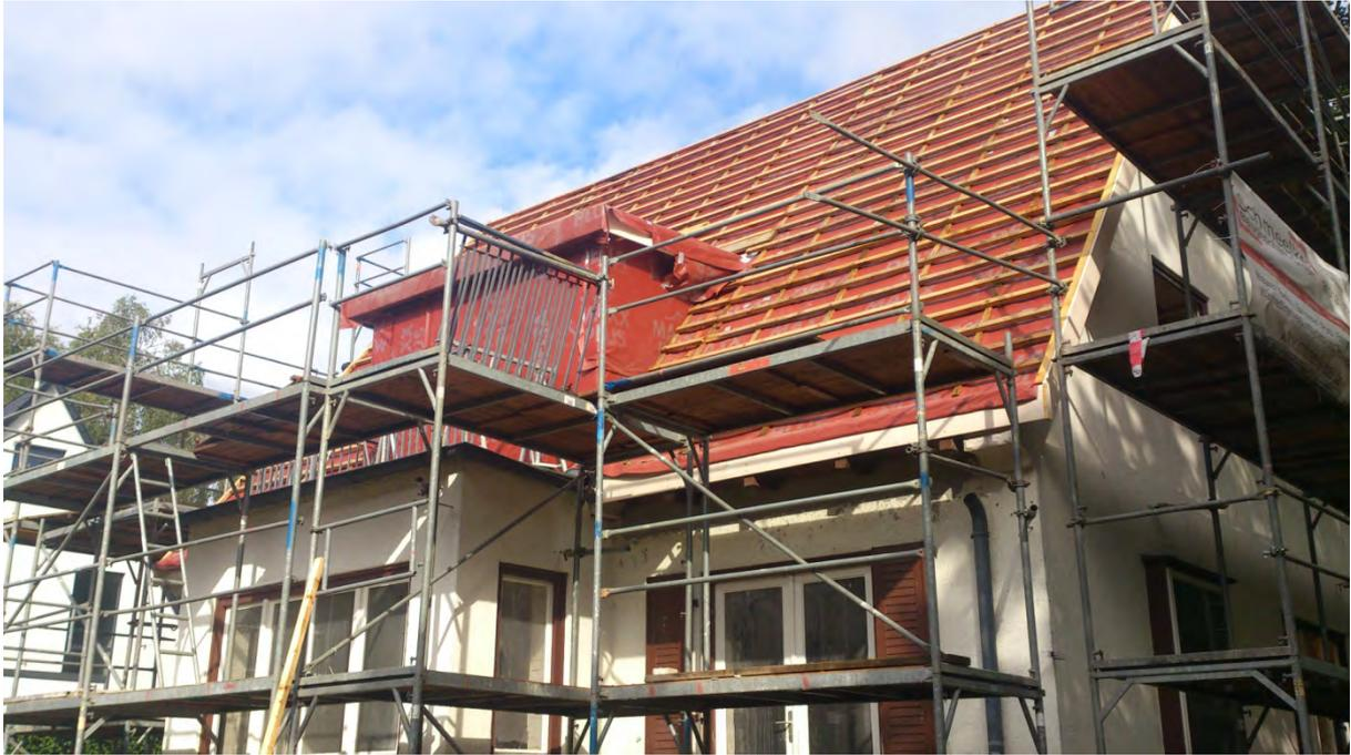
Für neue Dacheindeckung vorbereiteter Dachstuhl sowie neu erstellte Gaube
