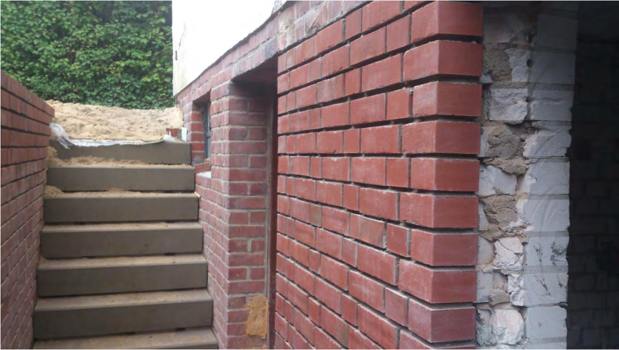
Neu erstelltes Sichtmauerwerk im Kellerniedergang
