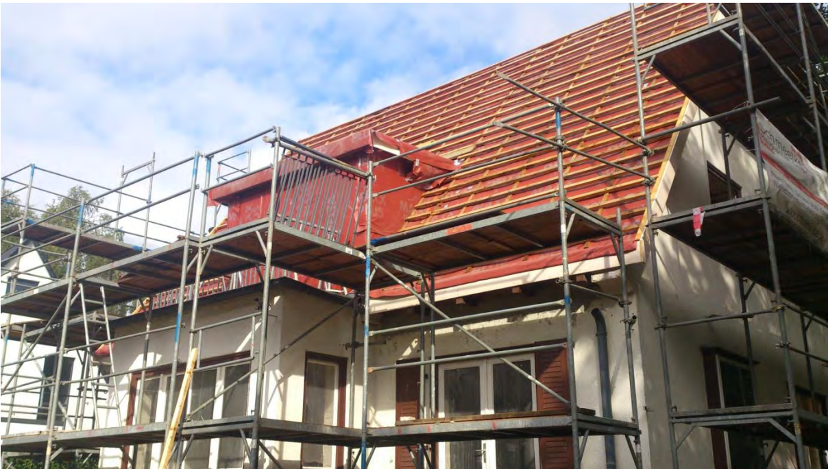
Für neue Dacheindeckung vorbereiteter Dachstuhl sowie neu erstellte Gaube
