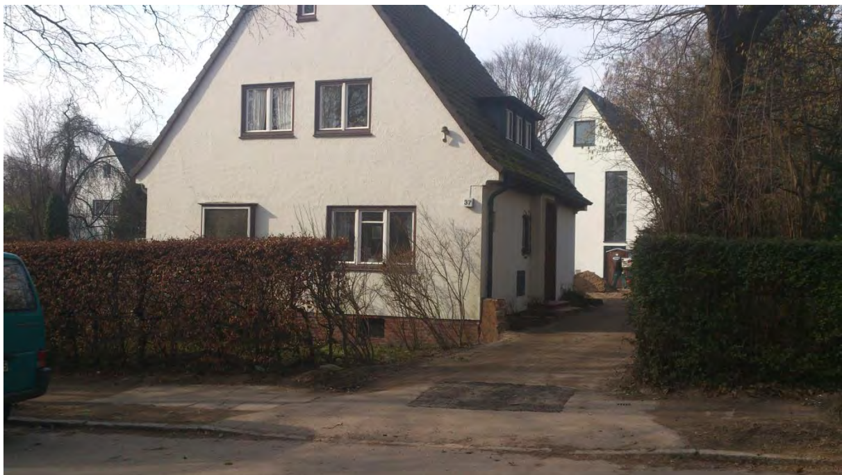
Altbau vor Beginn der Baumaßnahme
