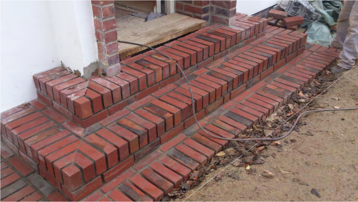
Neu erstelltes Eingangspodest
