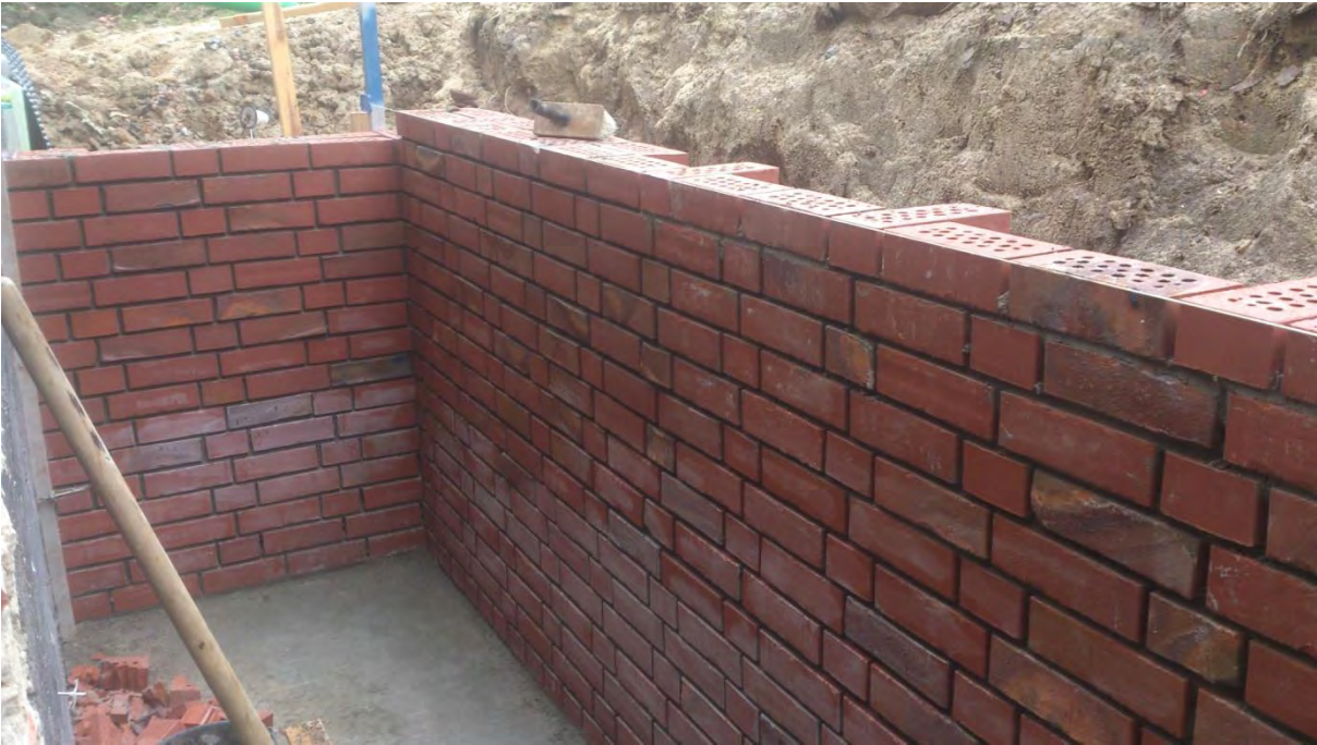
Sichtmauerwerk des Kellerniederganges
