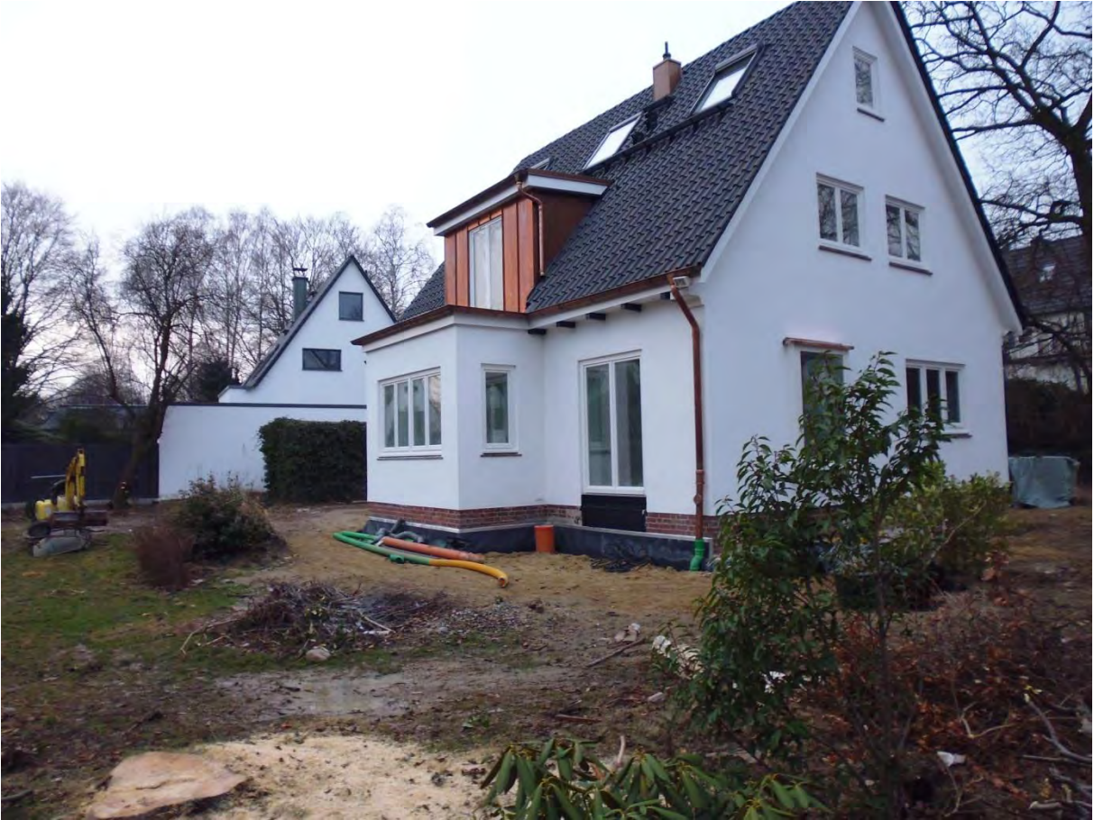
Saniertes Gebäude kurz vor Fertigstellung
