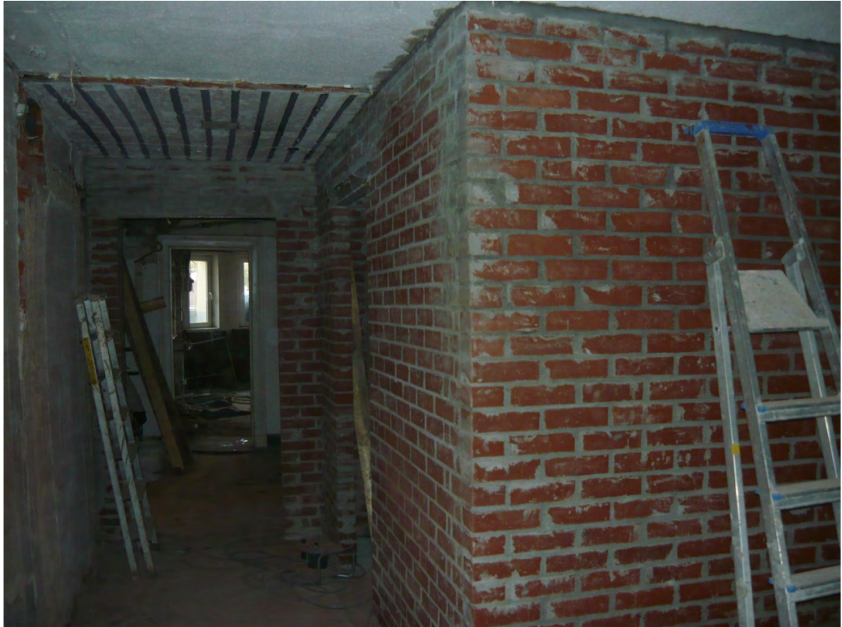
Neu erstelltes Innenmauerwerk im Kellergeschoss
