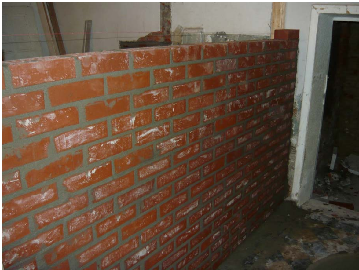
Neu erstellte Innenwände aus kleinformatigen Mauerziegeln
