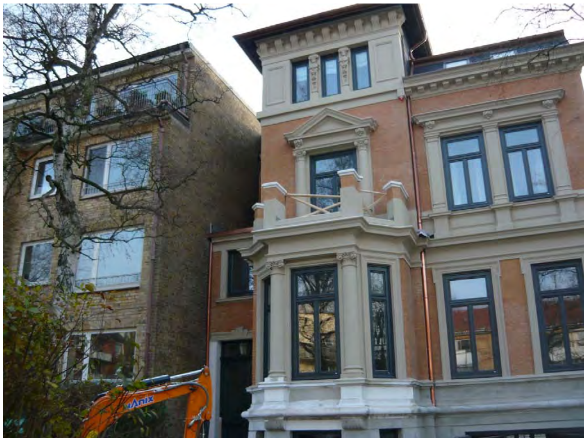
Straßenansicht nach Fertigstellung der Maurerarbeiten an der Fassade
