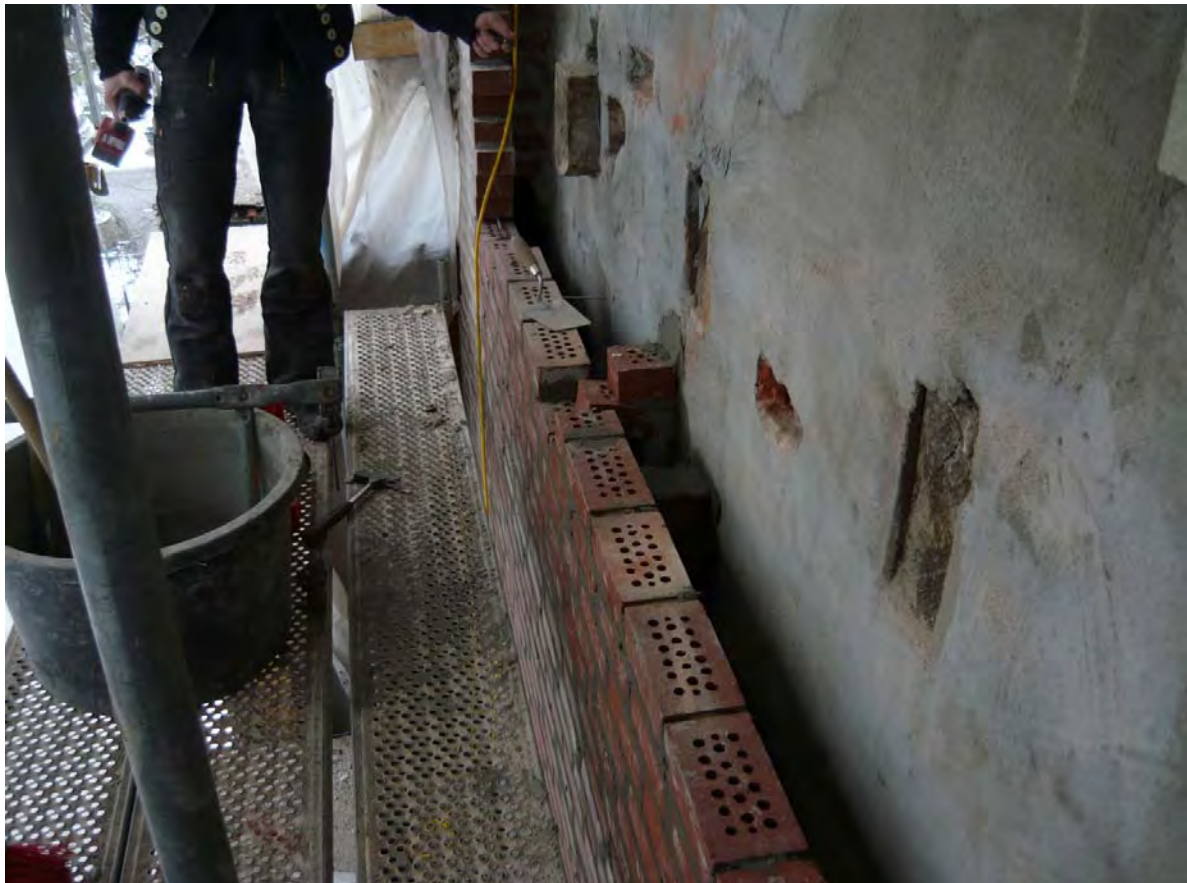
Neu hergestelltes Gieblaußenmauerwerk aus kleinformatigen Mauerziegeln
