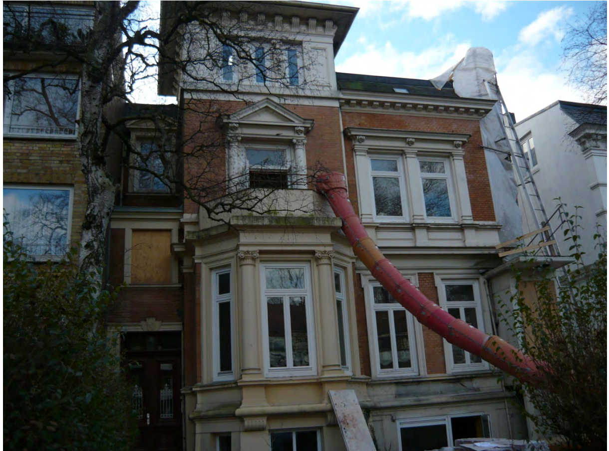
Straßenansicht bei Beginn der Rohbauarbeiten
