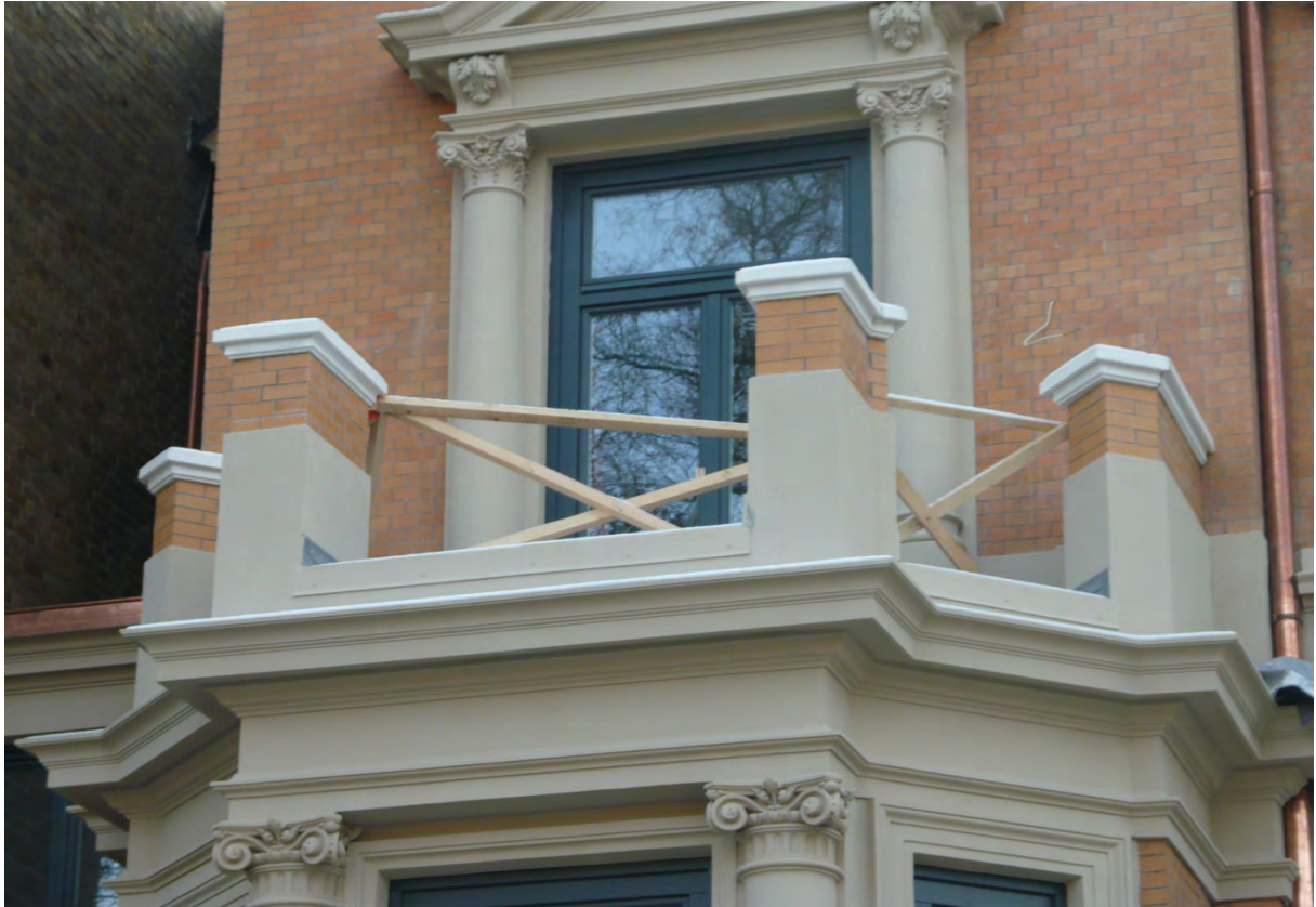
Neu erstellte Mauerwerkspfeiler auf dem vorderen Balkon
