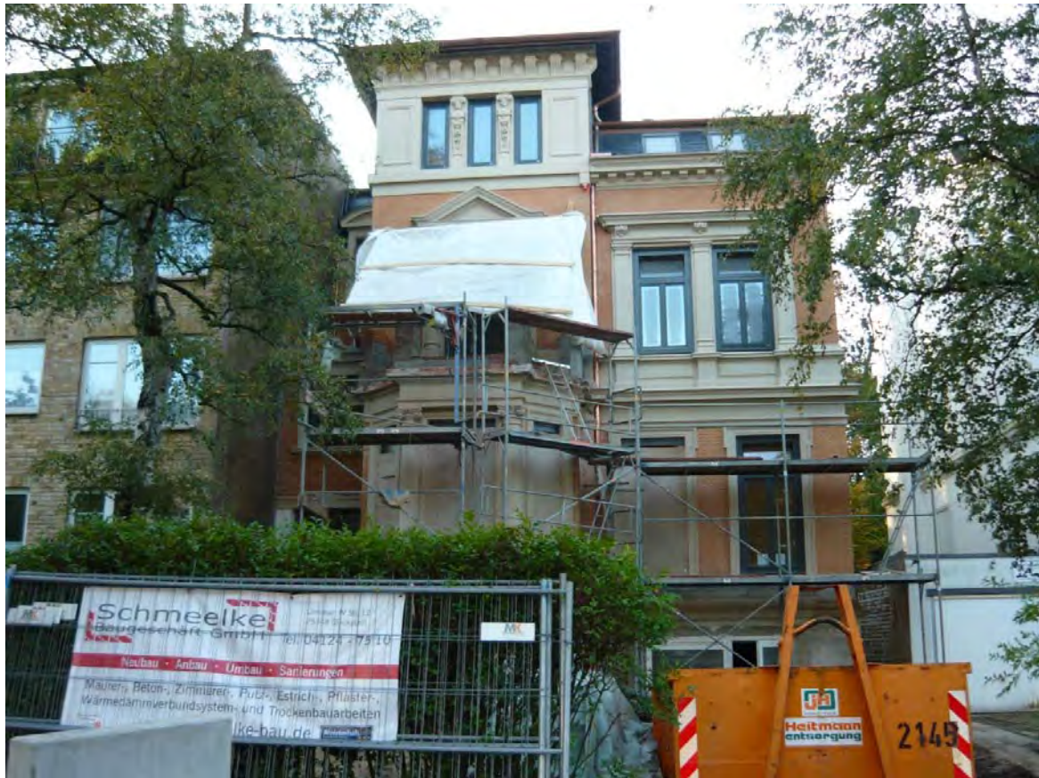
Straßenansicht während der Rohbauarbeiten
