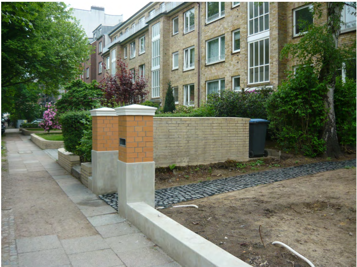
Neu erstellte Mauerwerkspfeiler als Begrenzung zum öffentlichen Gehweg
